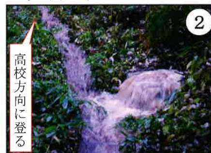
道路途中にある枡から溢れている
